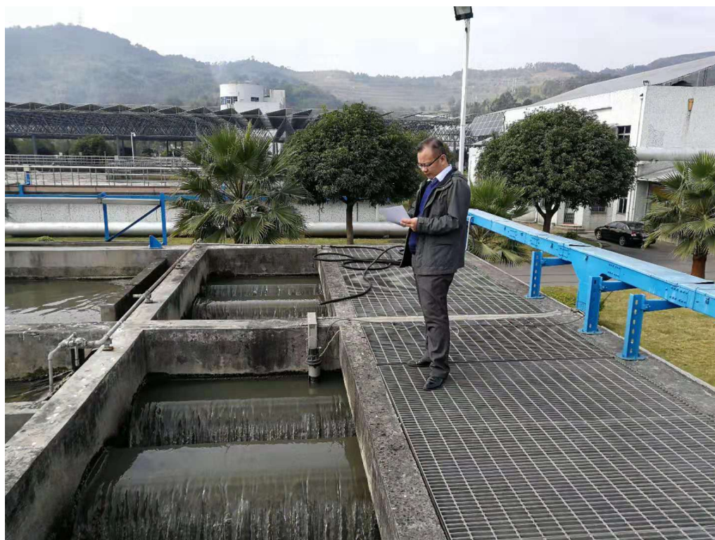
不符合项纠正措施现场验证图片
